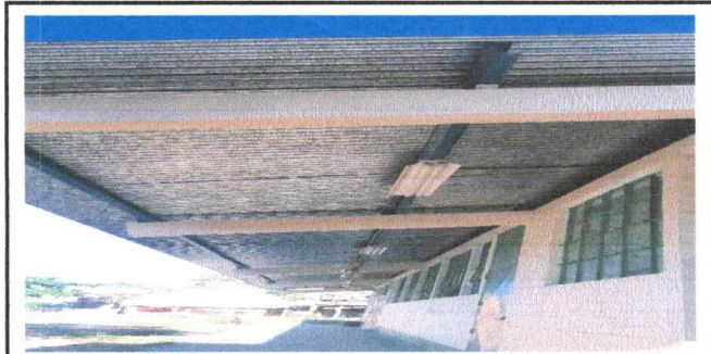
Se observa el entechado del establecimiento
